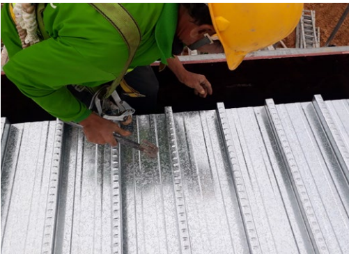
Bước 2: Liên kết tấm sàn LYSAGHT® BONDEK® II vào cốppha dầm bằng đinh thép và dán băng keo chống tràn bê tông
