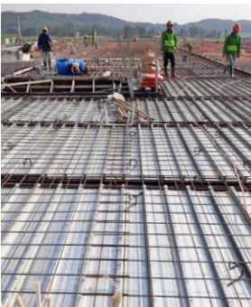
Bước 3: Lắp đặt lớp cốt thép dầm sàn và bố trí hệ MEP âm sàn (nếu có)
