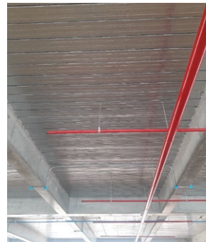
Bước 5: Lắp đặt hệ MEP hoặc hệ trần nếu có
