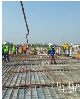
Bước 4: Tiến hành đổ bê tông sàn
