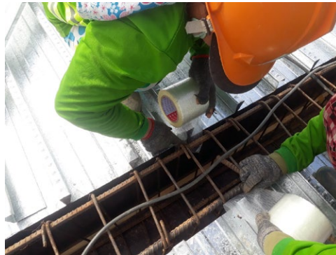
Bước 2: Liên kết tấm sàn LYSAGHT® BONDEK® II vào cốppha dầm bằng đinh thép và dán băng keo chống tràn bê tông
