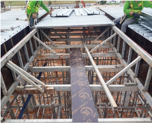
Bước 1: Lắp đặt các tấm sàn LYSAGHT® BONDEK® II vào hệ cốppha dầm bê tông và lắp đặt hệ chống nếu cần
