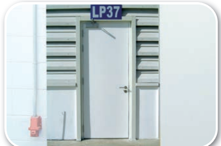
Emergency Door : ประตูฉุกเฉิน
