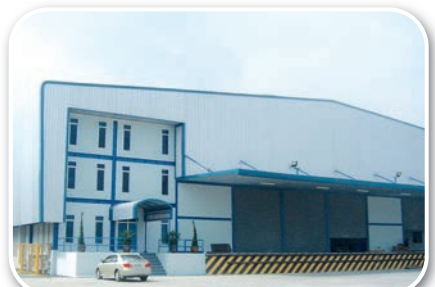
Office Building : อาคารสำนักงาน
