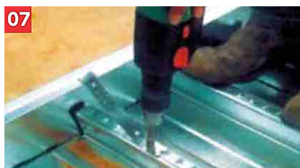
7 Fix steel edge form
