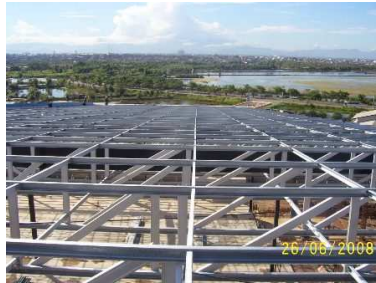
1. Purlin sudah terpasang
