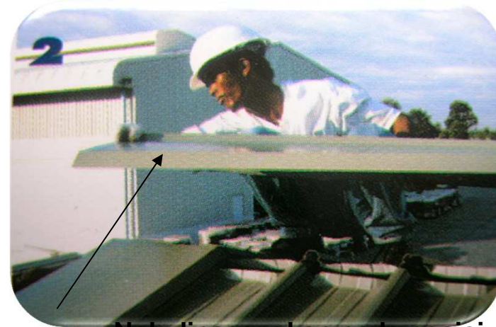
Nok dipasangkan pada posisi Yang tepat
