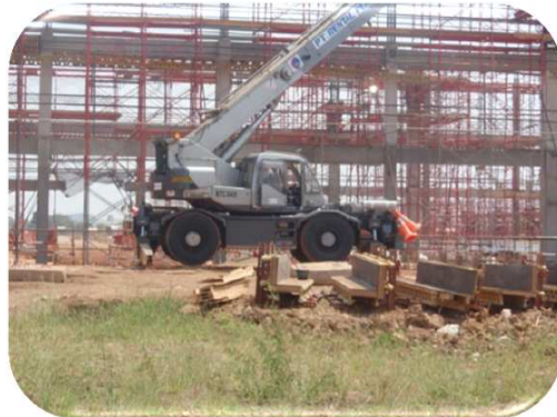
4. Crane kapasitas min 25 Ton , min jangkauan 6 m'.
