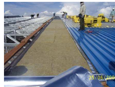
5. Pasang insulation Bila ada sesuai spesifikasi
