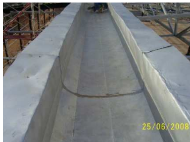
2. Talang sudah terpasang
