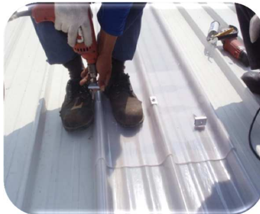
4. Pasang Tranlucent/ diberi sealant pada sambungan dan beri pengunci / screw
