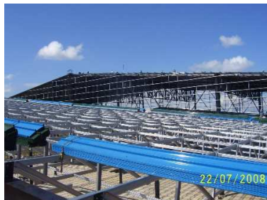
3. Material sudah di naikan
