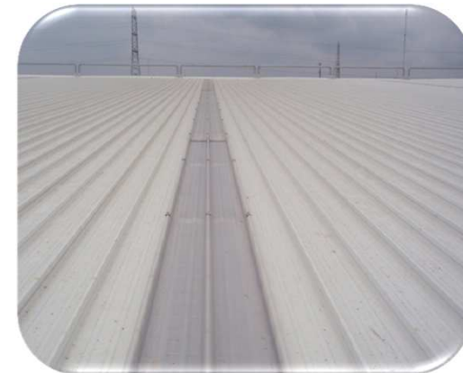
3. Pasang Tranlucent/ diberi sealant pada sambungan.
