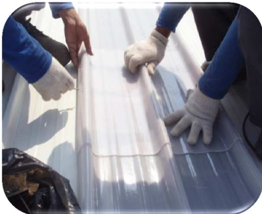
4. Pasang Tranlucent/ diberi sealant pada sambungan dan beri pengunci / screw
